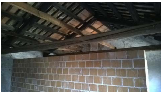
Parti al piano primo e sottotetto al grezzo con interventi strutturali incompleti.
