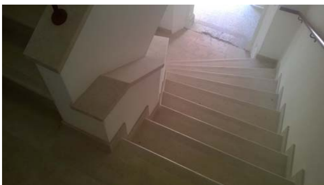
Scala esistente completa di finiture fino al piano primo.
