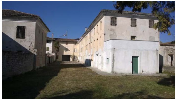
Vista del lato interno del fabbricato
