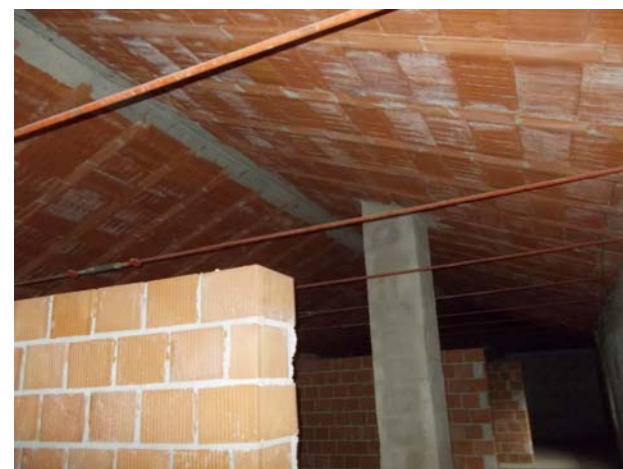
Copertura in laterizio esistente, corpo B.
