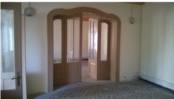
Parete divisoria e serramento interno in corrispondenza di due stanze senza vuoto sanitario
