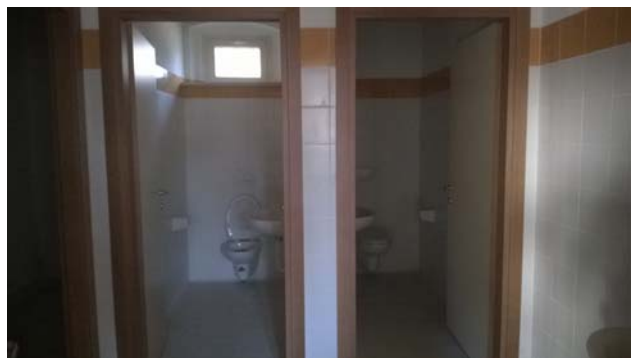
Vista sui bagni centrali già realizzati
