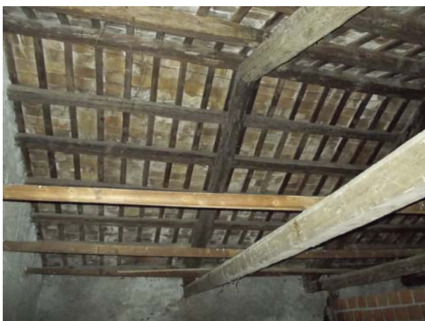
Copertura in legno e tavelle esistente, corpo B
