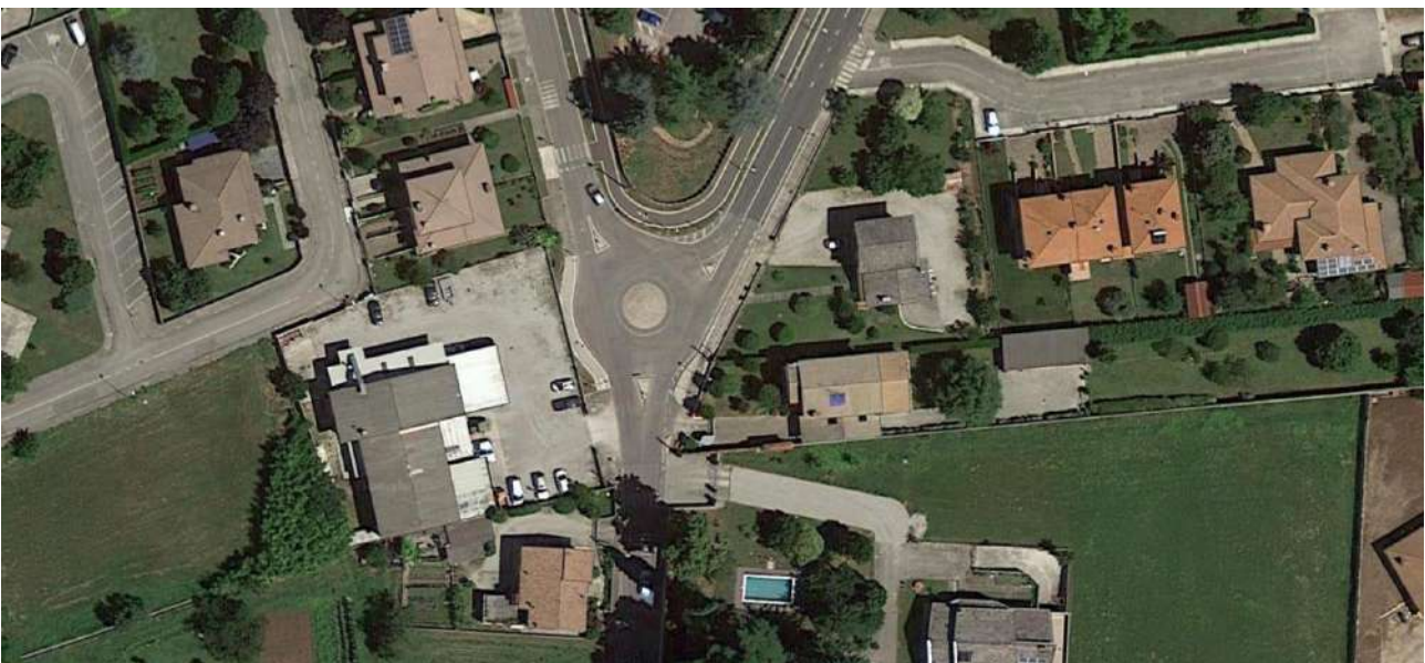
Immagine 18: Intervento di inserimento rotatoria presso plesso scolastico – frazione di Sedegliano.
